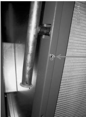
Avec rivets de  $\varnothing 6.4$ , monter le cache collecteurs fourni avec le kit d'adaptation, et fixer la batterie aux flancs avant et arrière du V.
